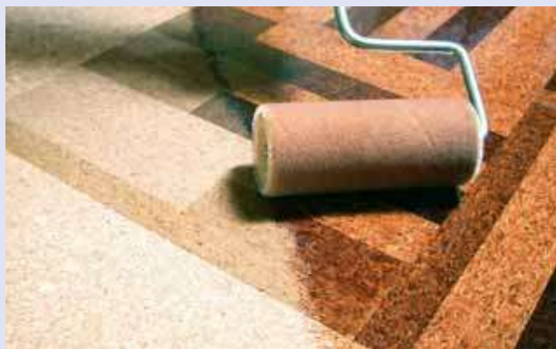
Einölen von Korkboden
