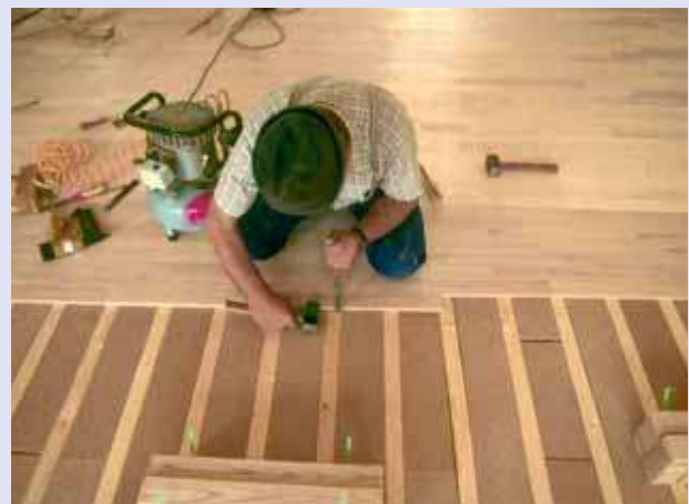
Lagerholzkonstruktion
