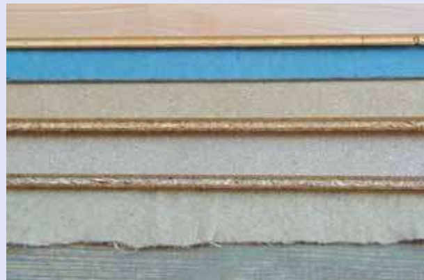
Fertigteilestrich mit Tannin-Spanplatten-Doppellage
