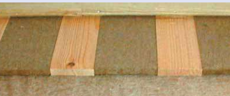
Trittschalldämmung Jutefilz/Holzweichfaser mit Lagerholz/Parkett
