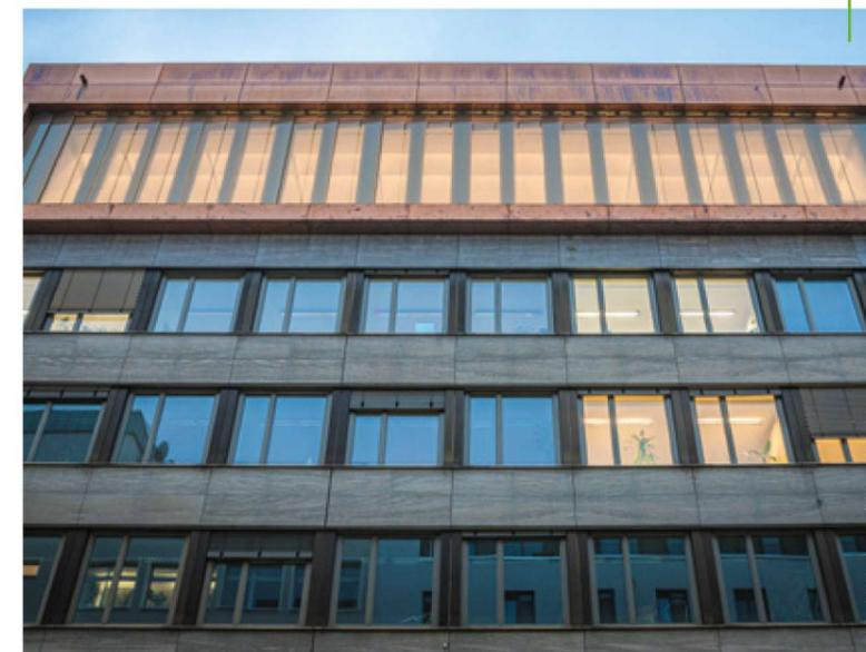
Aufgrund der Tragfähigkeit der darunterliegenden Etagen wurde für den Plenarsaal im fünften Geschoss eine leichte Holzbauweise gewählt.
